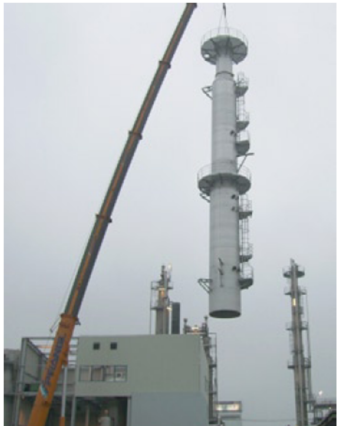
45 Meter Hoch ist der Spezialtank, der in mehreren Teilen geliefert und vor Ort montiert wurde.
